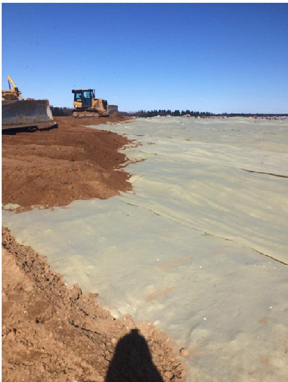
Рисунок 4 – Слой геотекстиля и грунта.
