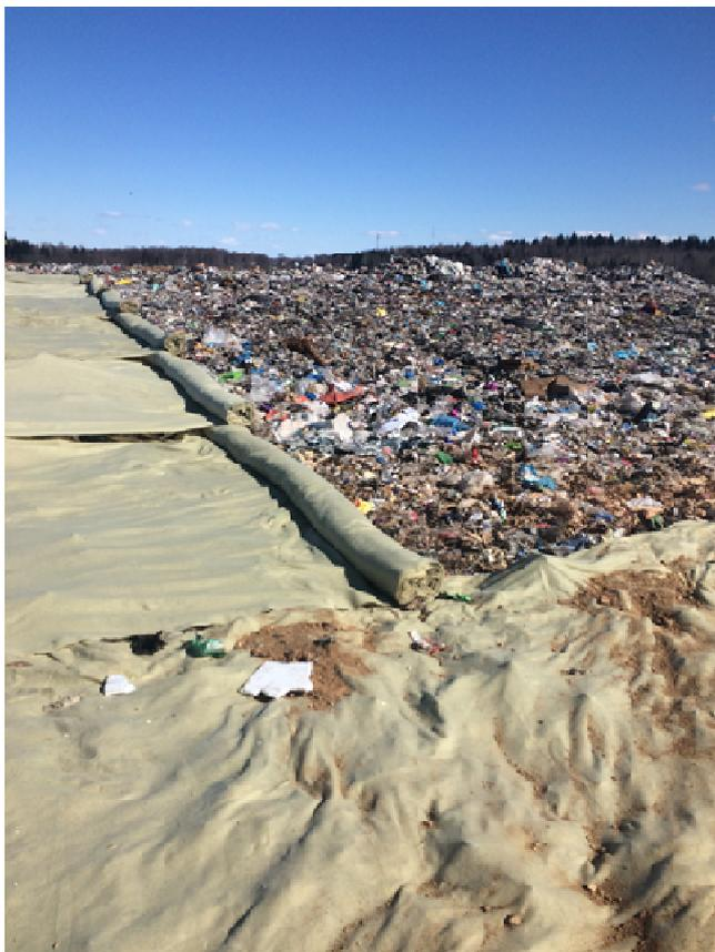
Рисунок 3 - Поверхность отходов, слой геотекстиля.
