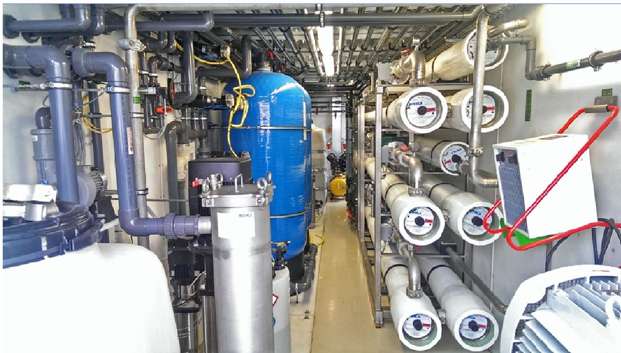
Рис. 6 - Внешний вид контейнерной установки обратного осмоса по очистке фильтрата полигона
